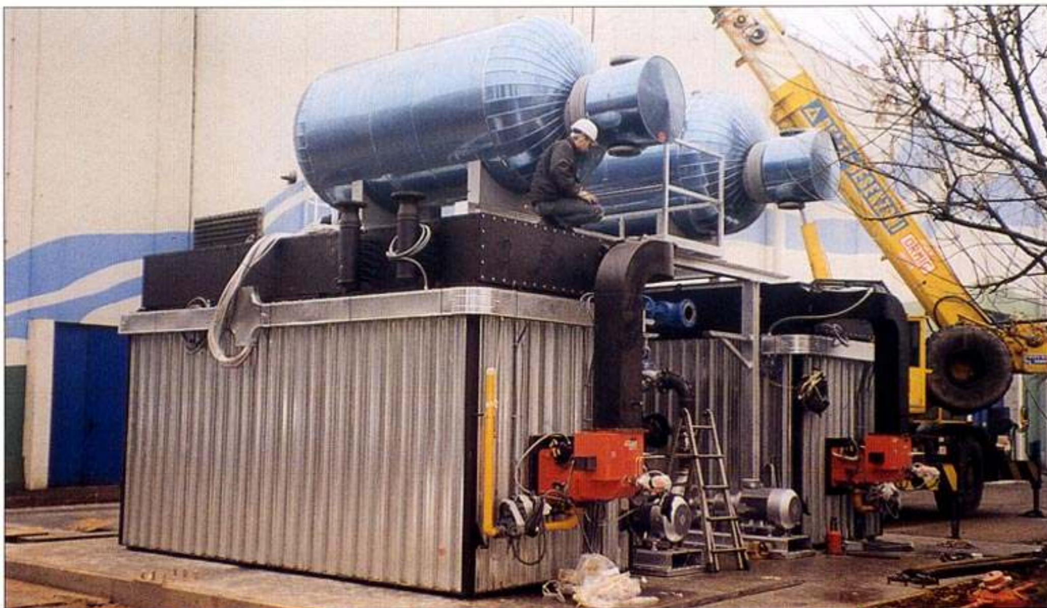
Fase di montaggio di un gruppo per produzione di vapore a calore indiretto composto da due PT 3000 E e due GV 5000/15
