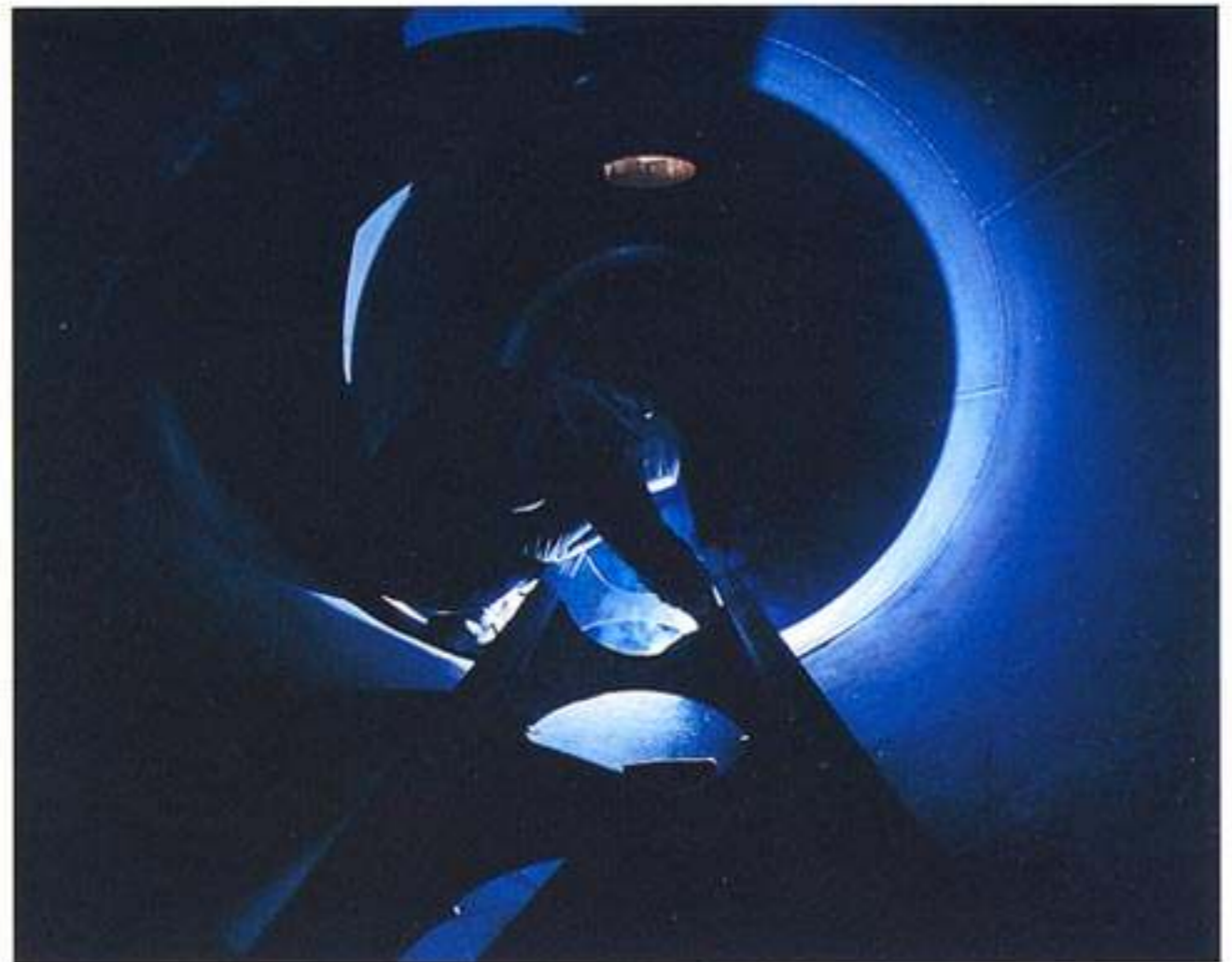
Fase di lavorazione di un Produttore di vapore
